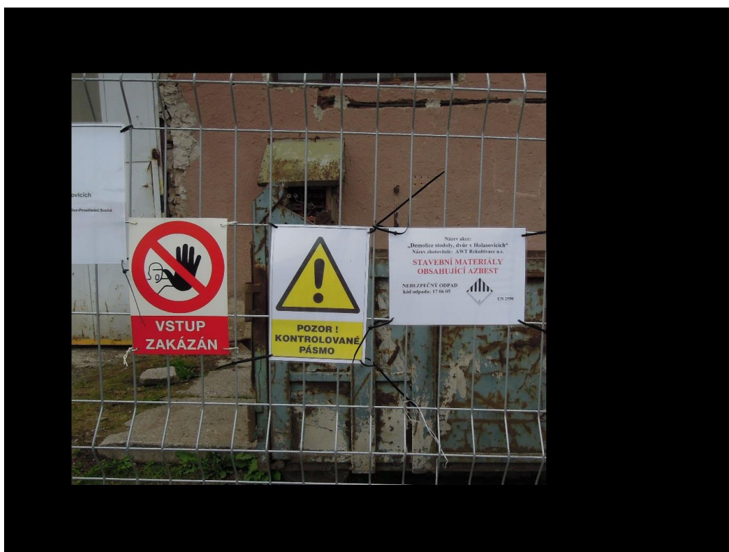
Označení stavby, při které jsou odstraňovány stavební materiály s obsahem azbestu
