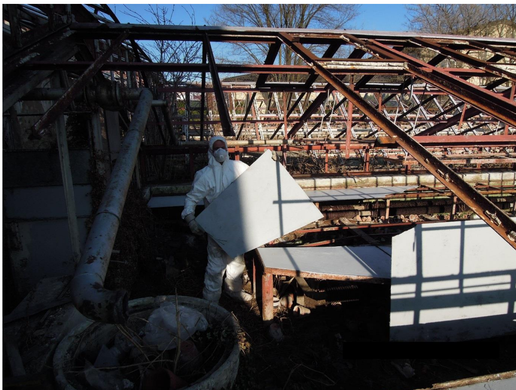
Zaměstnanec manipulující s materiálem obsahující azbest, vybavený odpovídajícími osobními ochrannými pracovními prostředky
