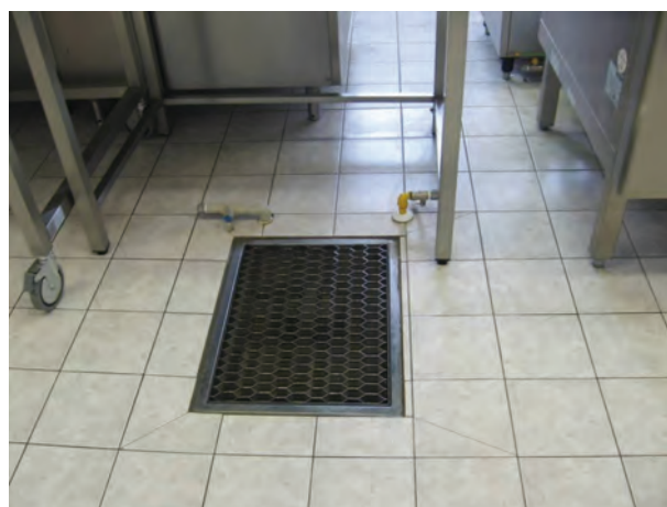
Obrázek 15: Kontrola po provedené opravě
