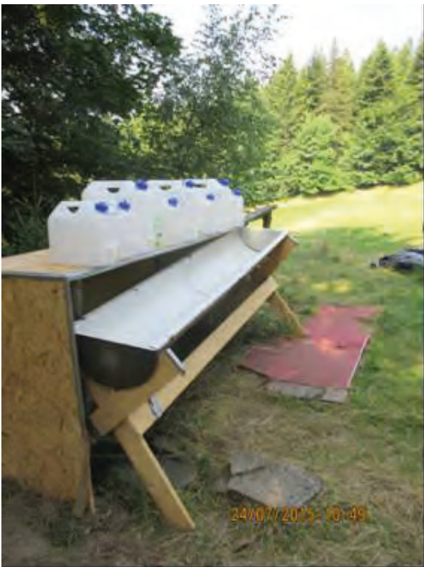
Obrázek 19: Umývárna ZA po kontrole (korýtko s více výtoky vody na mytí a zajištěným odtokem)
