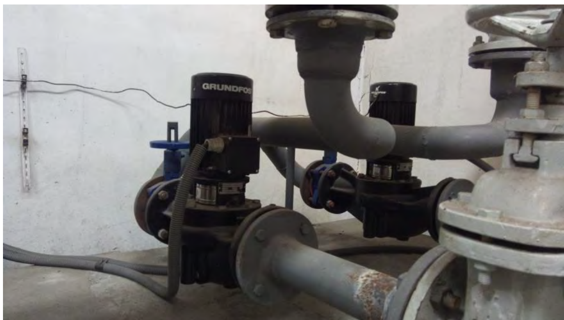
Obrázek 8 - Oběhová čerpadla
