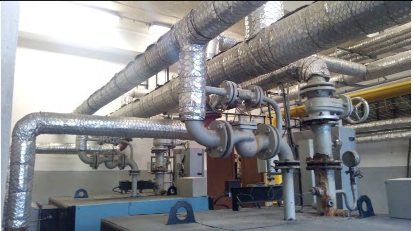
Obrázek 5 - Vyvedení výkonu z kotlů K2 a K3.
