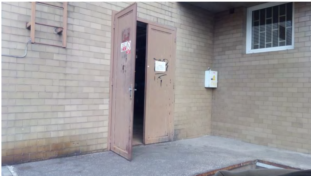
Obrázek 1 - Vstup do kotelny z vyvýšené podesty.
