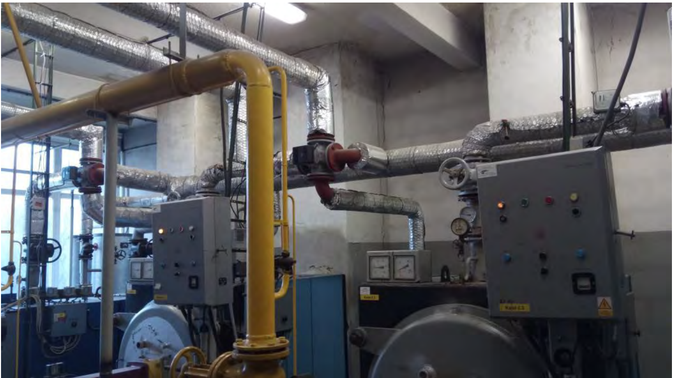
Obrázek 6 - Vyvedení výkonu z kotlů K2 a K3
