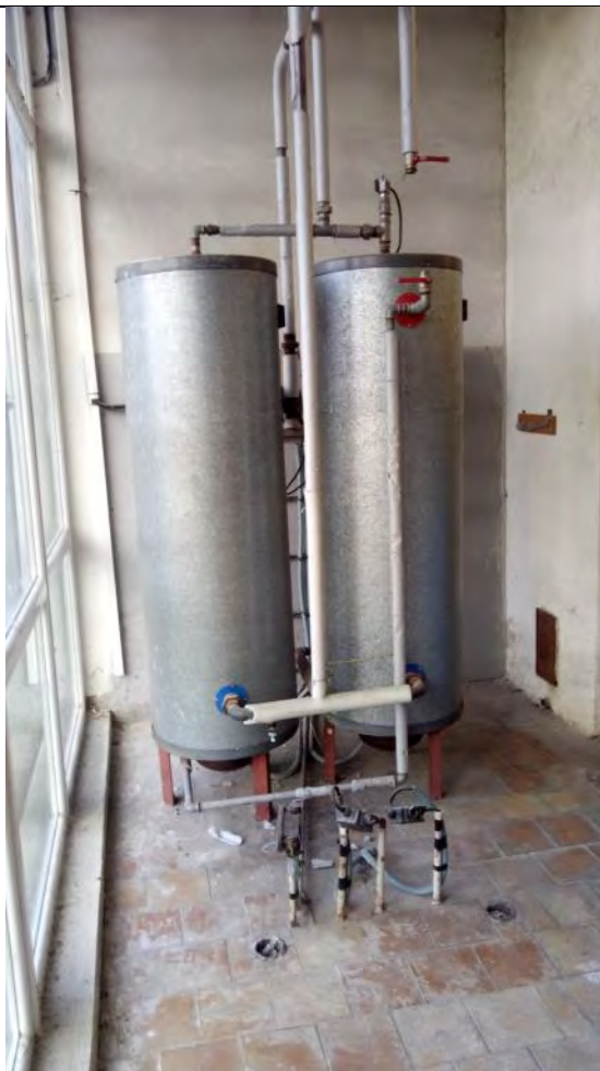
Obrázek 9 - Zásobníky TUV určené k demontáži
