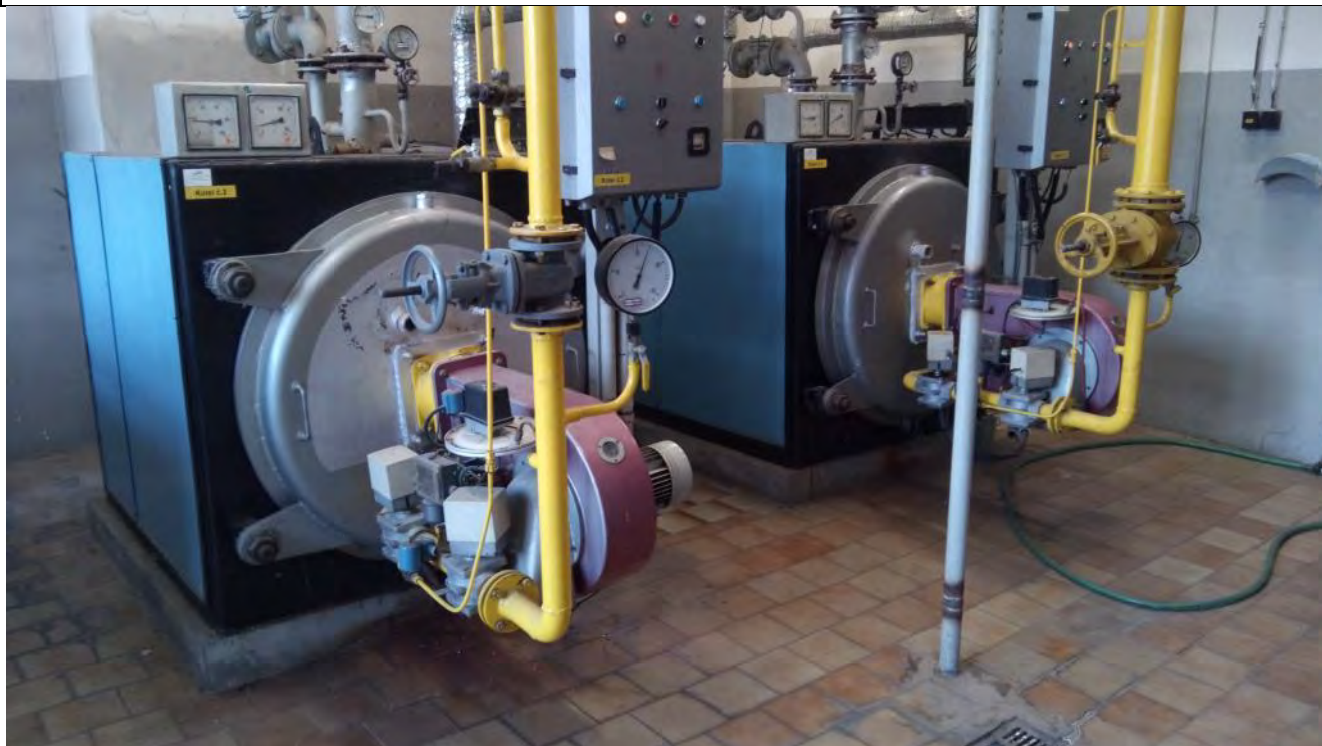
Obrázek 3 - Kotle K2 a K3. V rámci opravy přijde demontovat kotel K3.
